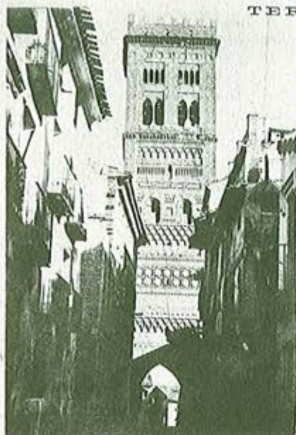
TORRE DE SAN MARTIN
